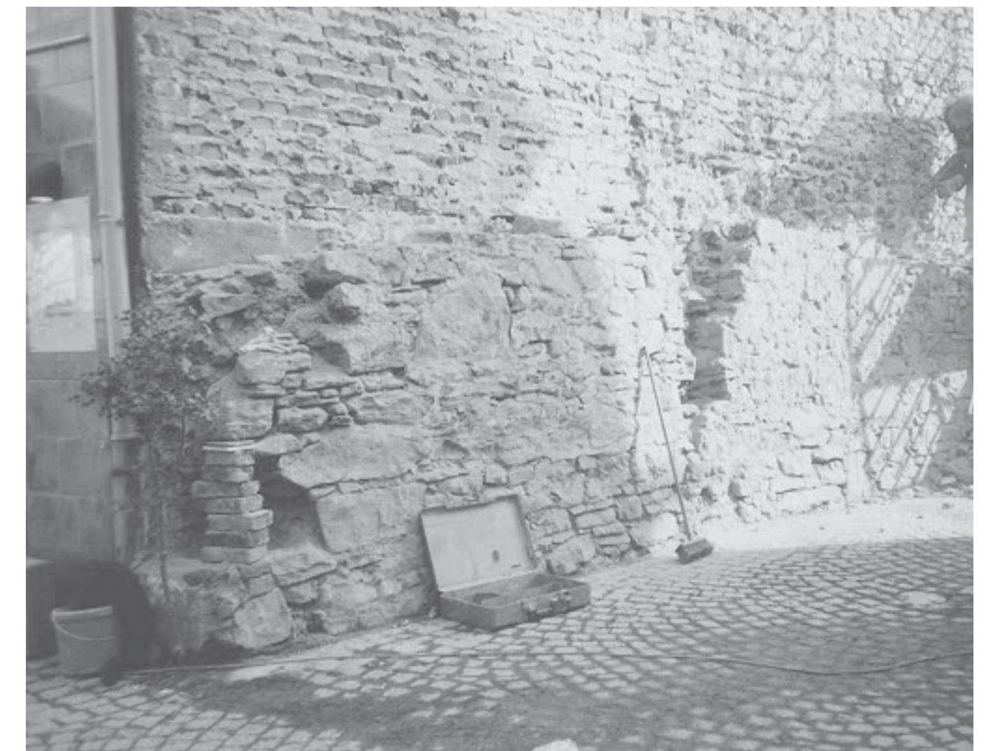
Die Mauer während der Sanierung 1998.
